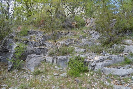
(A) Ancien front de taille en marches d'escalier montrant la progression de l'extraction guidée par les discontinuités horizontales et verticales de la masse rocheuse
